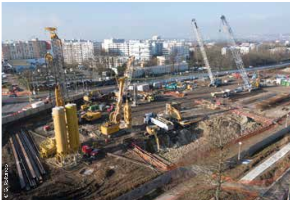
Les travaux en cours.
