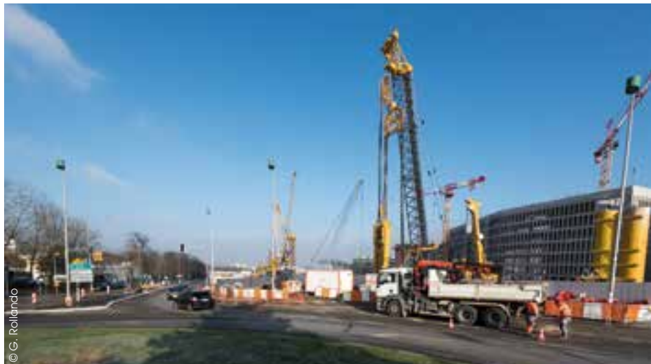
Une vue du chantier du Grand Paris Express.
