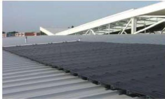
Exemples d'installations de moquette solaire sur couverture métallique
