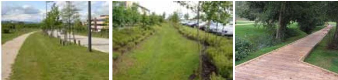
Exemples : noue engazonnée large- noue engazonnée avec massif de vivace – platelage bois pour le franchissement noue sur parking – Source : APS- Notice PAE et VRD
